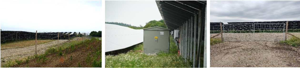
Figur 4 viser eksempler på hhv. nyplantet 3-rækket beplantningsbælte, transformerkiosk, inverter og hegnsport
